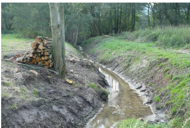
Obr. 15 a 16: Pročištění koryta odvodňovacího příkopu jižně od mokřadů Státním pozemkovým úřadem ČR v roce 2014.
